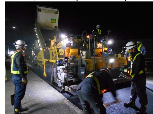
舗装修繕状況(イメージ写真)
