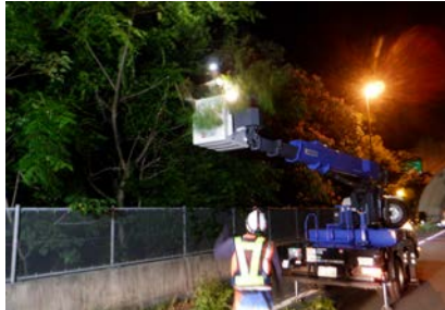
維持作業 (支障木伐採)
