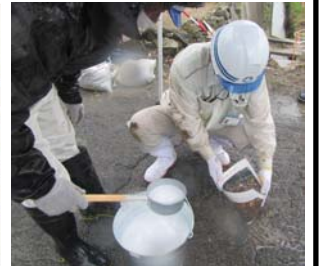
写真⑤: 石灰水の流し込み状況
