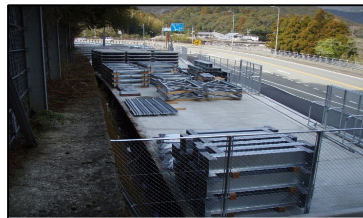
資材置き場(応急組立橋) 海部郡牟岐町河内東川又1747-10
