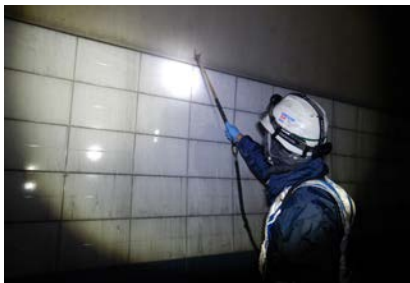
点検作業 (トンネル点検)
