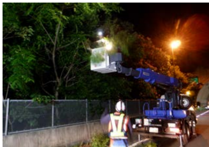
維持作業 (支障木伐採)
