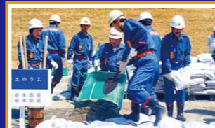
積み土のう工
