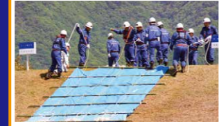
シート張り工
