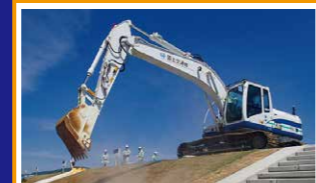
捨て土のう工
