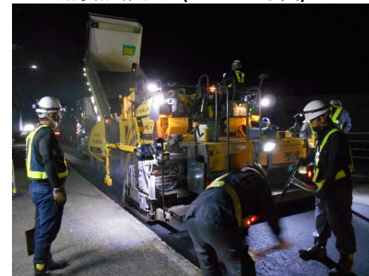
舗装修繕状況(イメージ写真)
