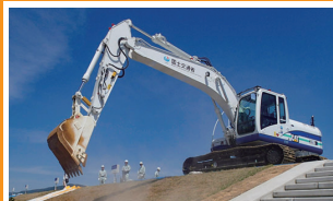
捨て土のう工 決壊対策工
