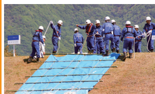
シート張り工 法崩れ対策工
