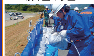
改良積み土のう工 越水対策工
