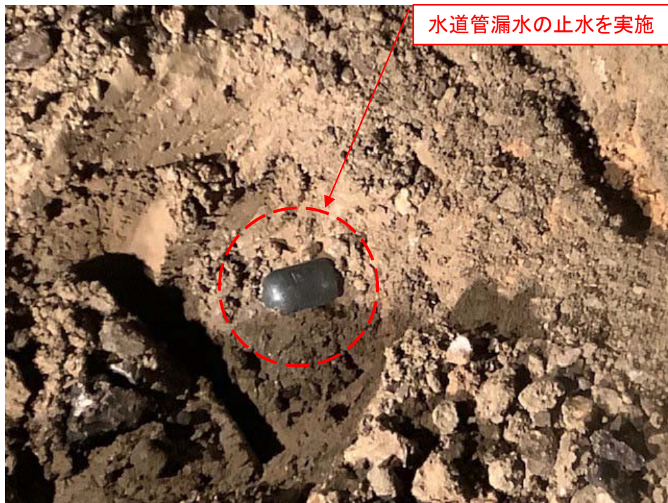
(堤防道路下の水道管)
