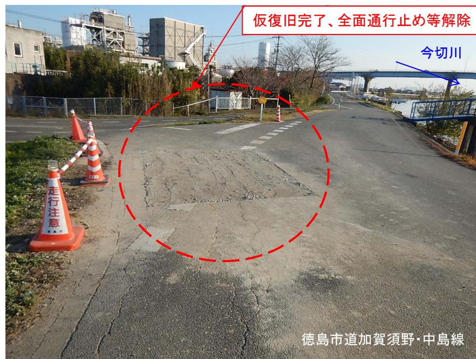
(堤防道路の仮復旧)
