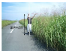
堤防の草の状況写真
