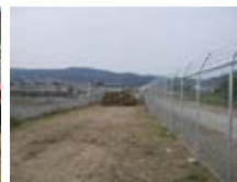
梱包材の仮置き状況写真
