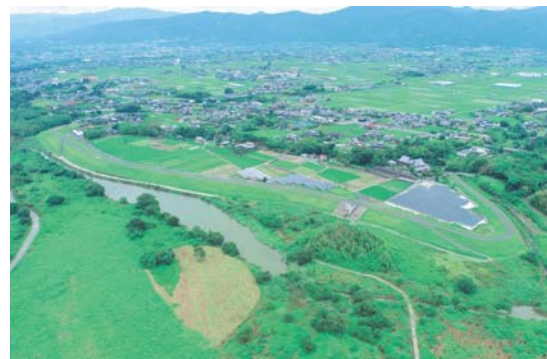
写真2 谷島堤防完成状況(下流より望む)
