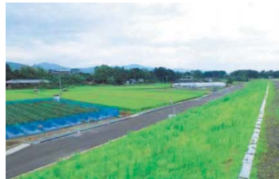
写真4 堤防整備と併せ市道を拡幅
