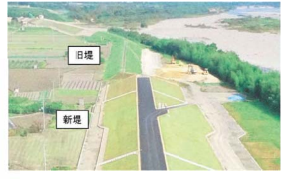
写真7(左)伊沢市堤防完成 状況(上流より望む)
