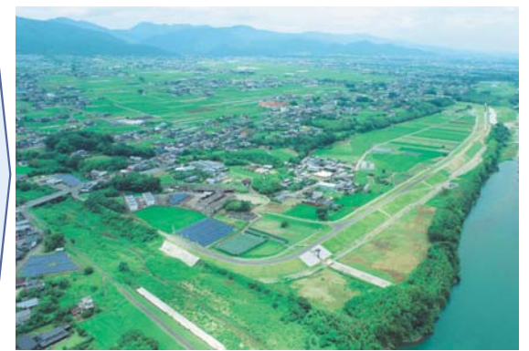
写真6 伊沢市堤防完成状況(上流より望む)
