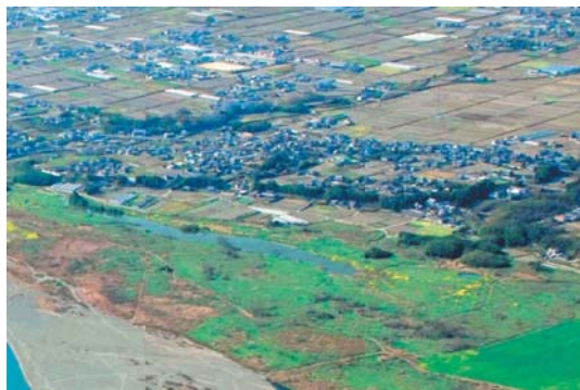
写真1 工事着手前(下流より望む)
