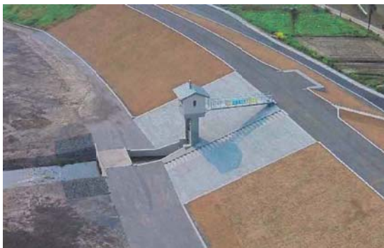
写真3 谷島樋門完成状況
