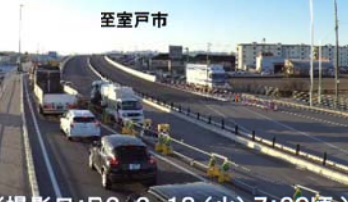
写真④:室戸市方面行き(開通前)
