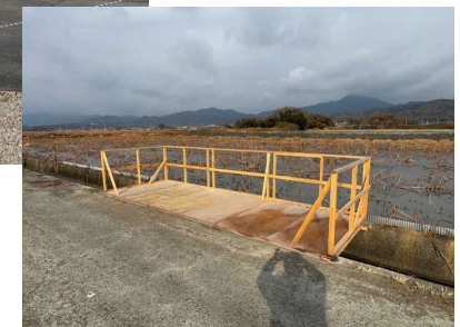
観察者用駐車場、観察足場の設置
