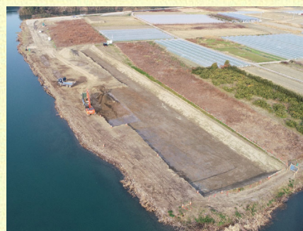
第1弾試験施工箇所整備状況
