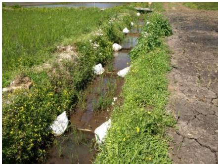
水路の堰上げ
