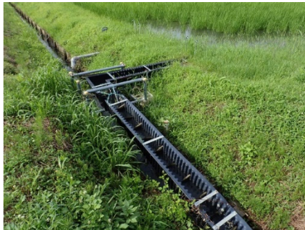
水田魚道の設置
