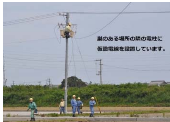
四国電力の協力による仮設電線工事の実施
