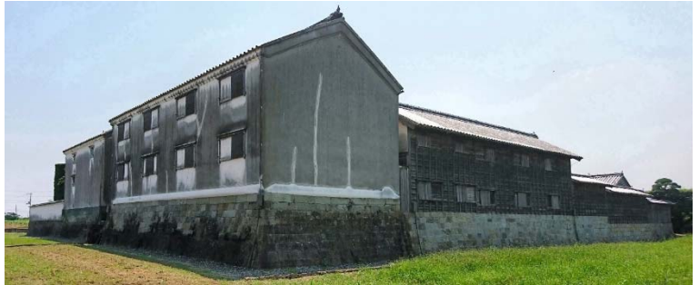
【図 13】石垣で嵩上げされた対策（石井町藍畑/田中家住宅）
