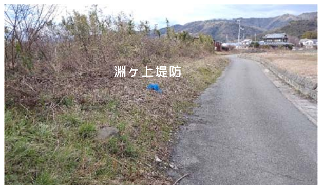
写真 3 淵ヶ上堤防（大津町大幸字淵の上）
