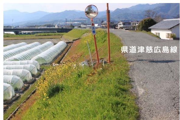
写真 12 現在のカルカ工堤防（大麻町津慈）
