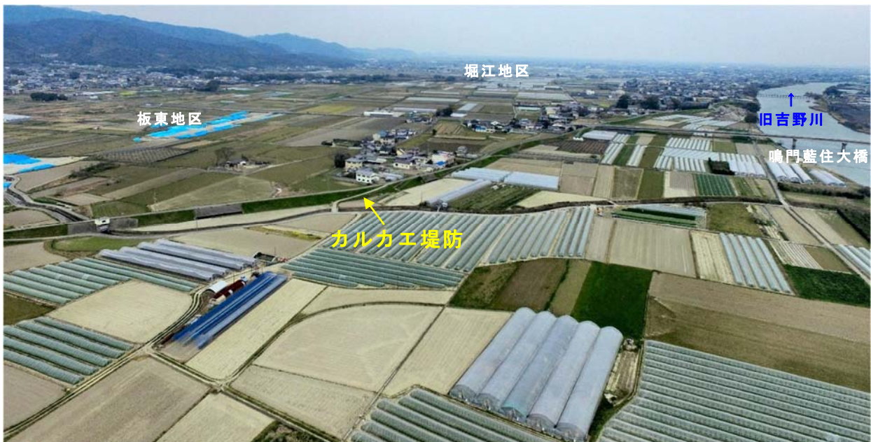
写真 13 カルカエ堤防（大麻町板東 東カルカエ付近）
