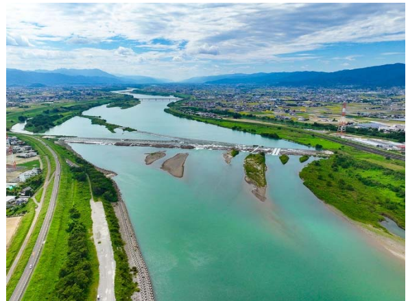
【写真1】現在の第十堰周辺（下流側から望む）
