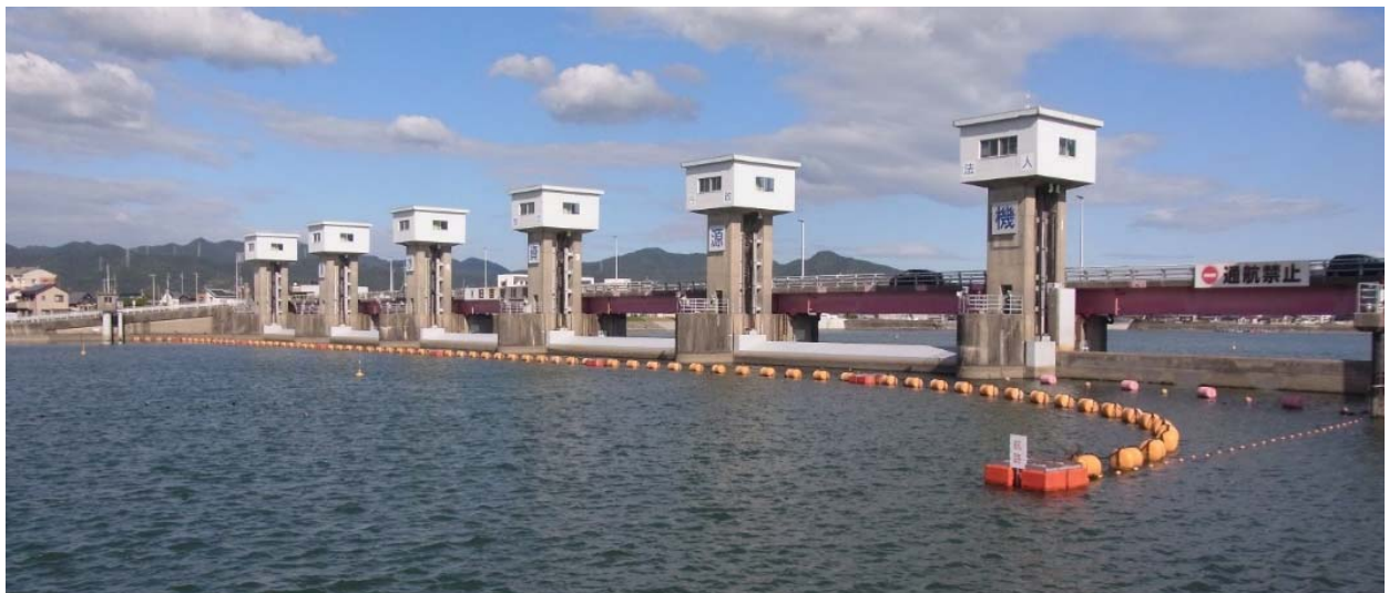
【写真6】海水の遡上を防ぐ（現在2代目）の「旧吉野川河口堰」
