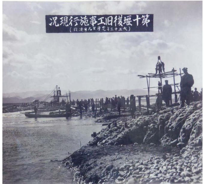
写真 6. 第十堰復旧工事（大正 13 年）
