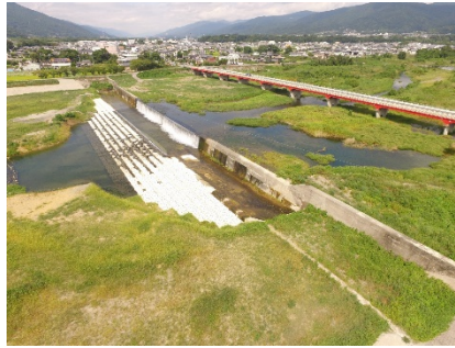
写真3-2.曾江谷川の床固工 (曾江谷橋下流)
