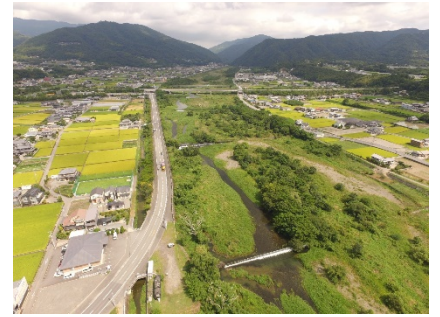
写真3-3.曾江谷川の床固工群を 下流から望む
