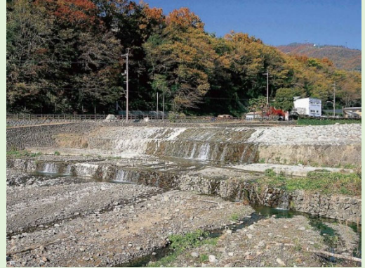
写真4. デ・レーケが関与したとされる大谷川砂防堰堤
