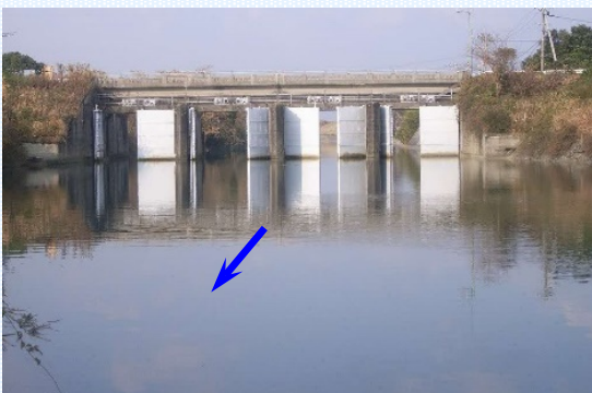
写真6 飯尾川第2樋門改築前
