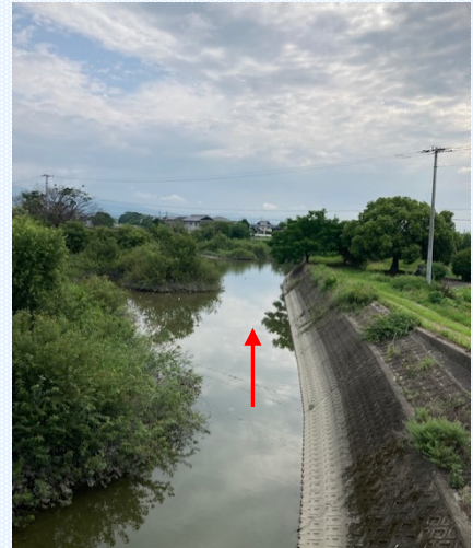
写真2 飯尾川（関）放水路
