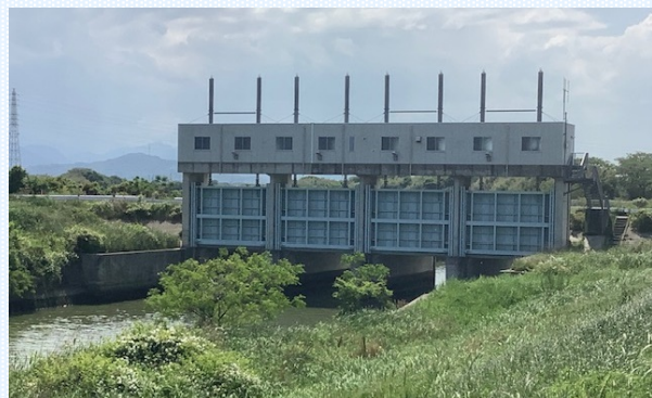
写真7 飯尾川第2樋門改築後
