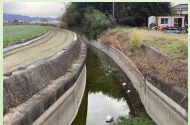
写真 3. 屈曲し狭隘な旧河道
