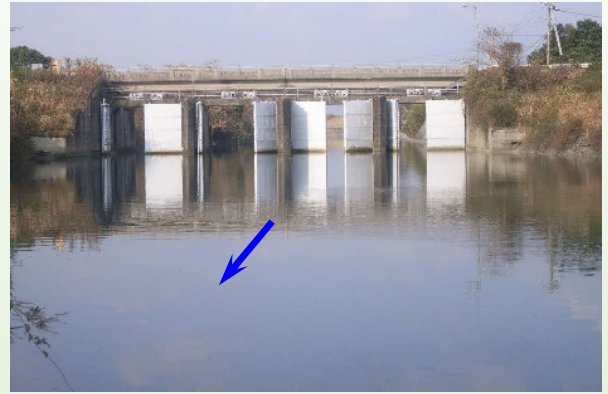
写真 2. 旧飯尾川第 2 樋門 (平成 23 年に改築)
