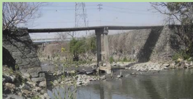
▶写真 4-2 加減堰下流端(平成24年)
