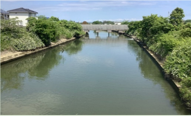
写真 1. 飯尾川第 1 樋門下流の新川開削河道
