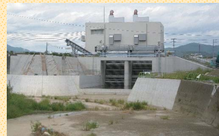
写真6 川島排水機場 (平成21年改築)
