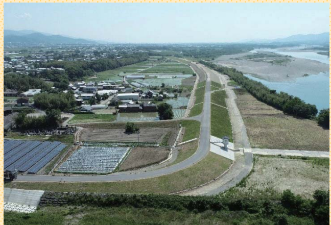
写真9 勝命堤防(伊予市工区)
