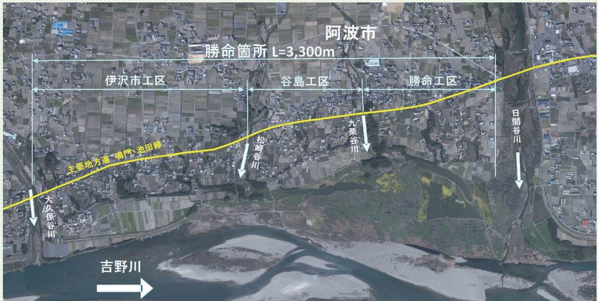
写真2 勝命箇所 空中写真
