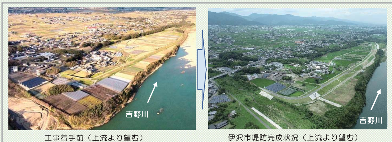
写真6 伊沢市工区築堤工事前後
