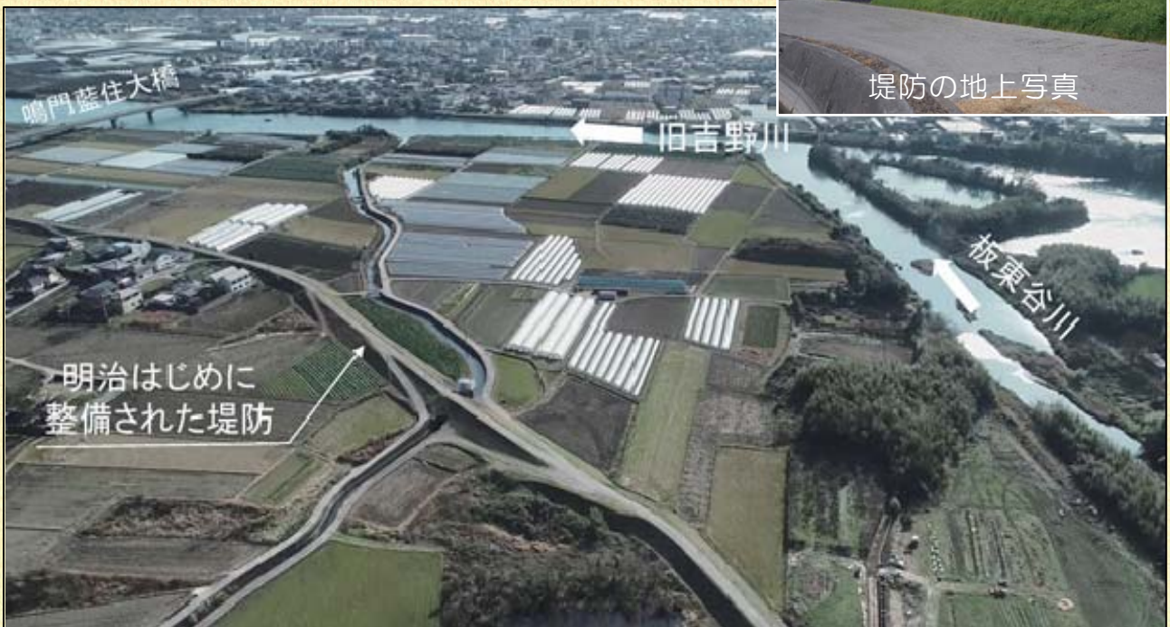
写真1 萱刈堤防(鳴門市大麻町津慈)
