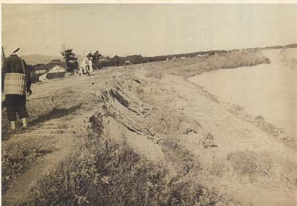
写真4 堤防決壊寸前の吉野川 (昭和 29 年9月ジューン台風)
