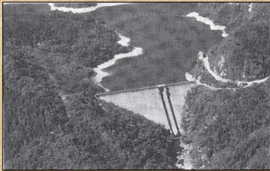
写真3 別子ダム（昭和41年2月完成）
