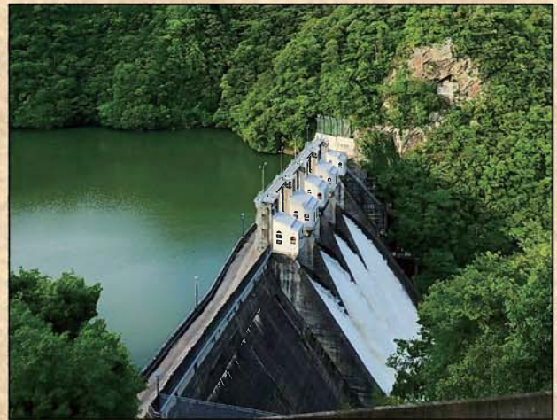
写真 4 柳瀬ダム（昭和 29 年（1954）竣工） 提供： 四国地方整備局 吉野川ダム統合管理事務所
