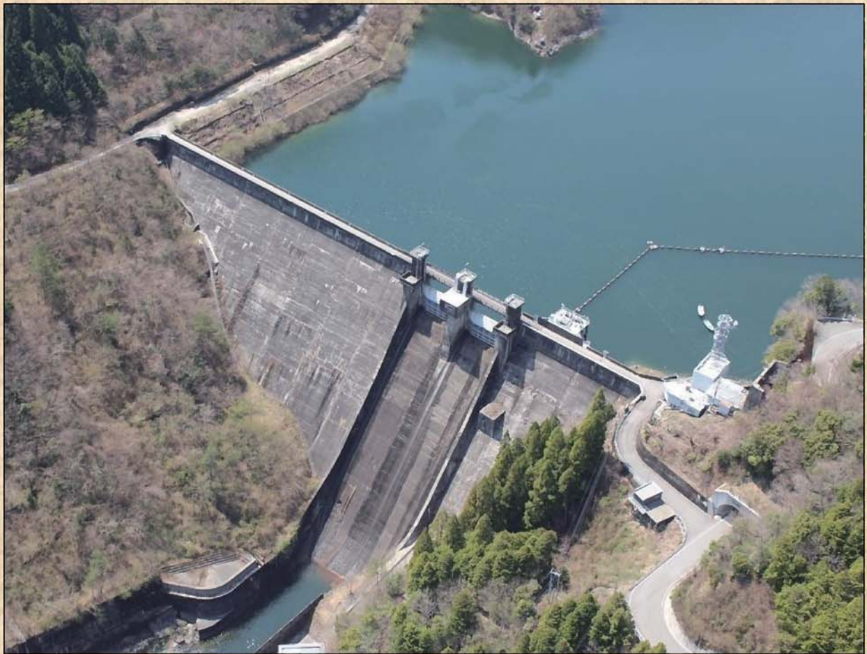
写真 1 長沢ダム（昭和 24 年（1949）竣工） 提供：四国電力株式会社 高知支店 技術部 本川水力センター
