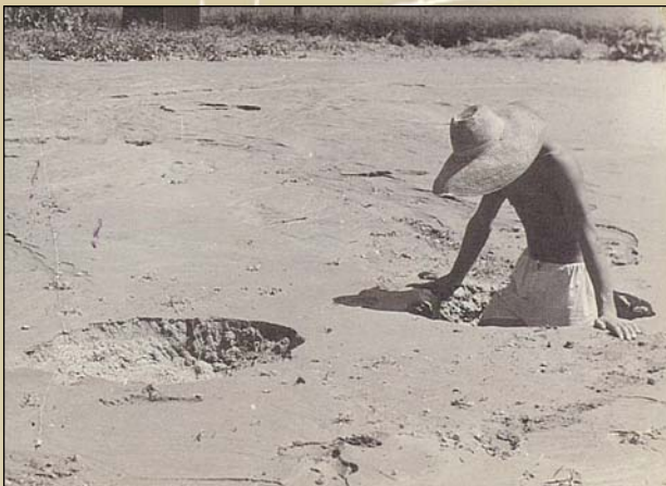
写真 4 洪水が浸透してできた大穴（ガマ） (昭和 29 年 9 月ジューン台風)
