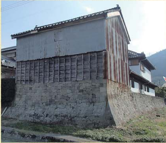
写真5 城構えの家 (美馬市穴吹町三島大塚氏宅) 水害を軽減するため、高石垣の地盤の上に家を築く「城構えの家」が見られます。
