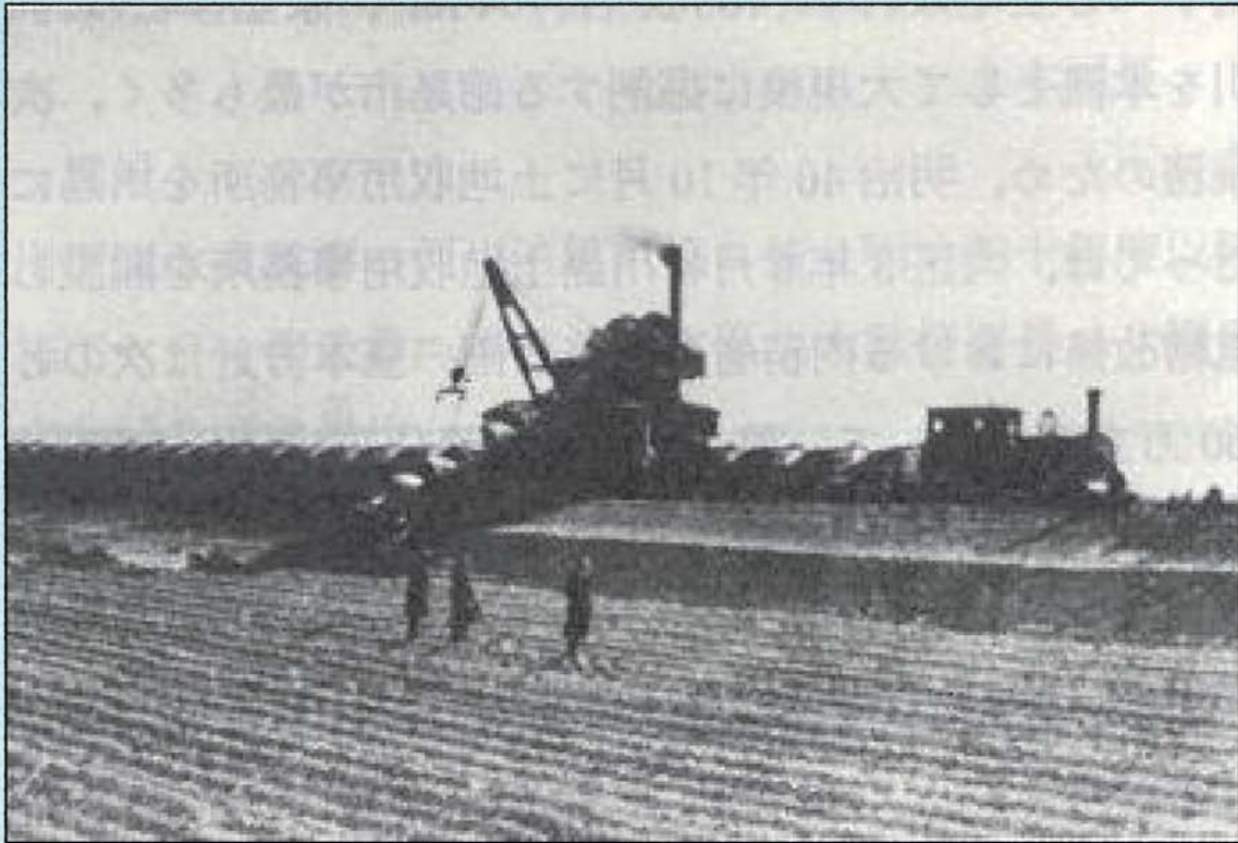
写真-3 機械施工状況写真
