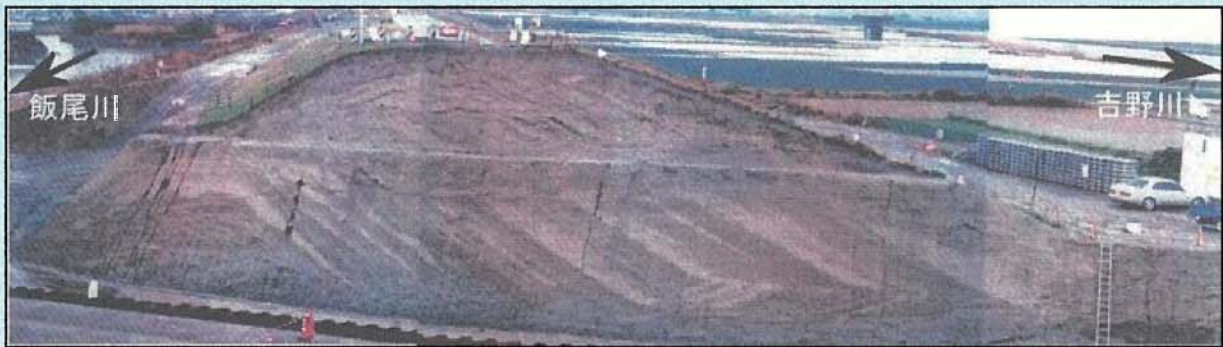
写真-2 堤防開削状況写真
