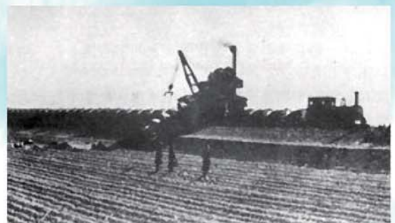
写真3 第一期改修工事風景
