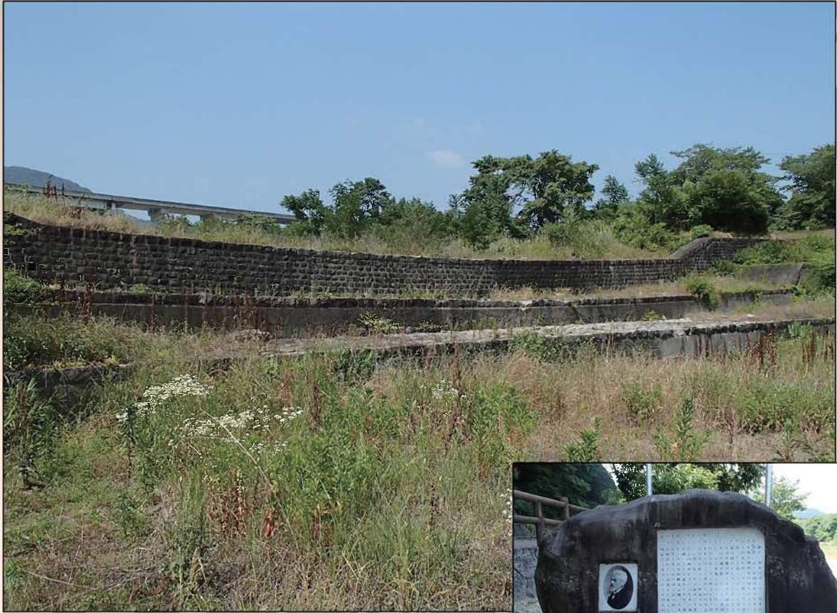
写真-2 デ・レーケが指導したと言われる砂防堰堤（美馬市脇町）
