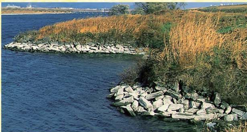
写真1：水制工〔吉野川右岸（南岸）、覚円付近〕
