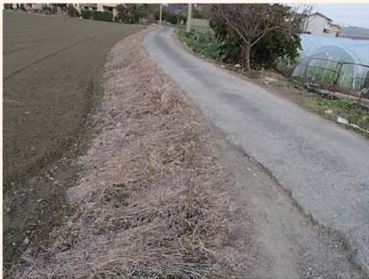
写真3 三ヶ村堤（旧堤防）
