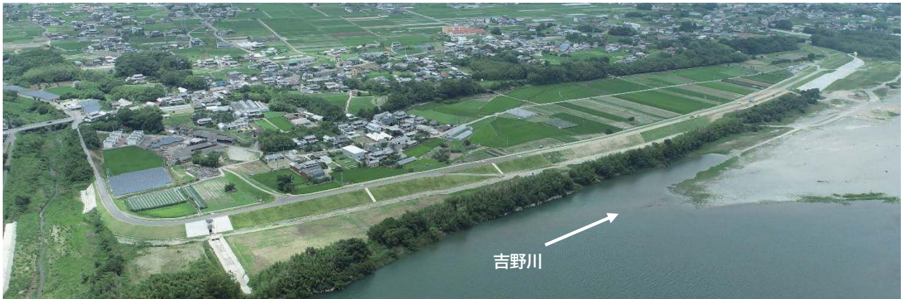
▲写真2. 勝命堤防（伊沢市工区）
