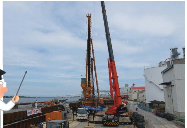
写真 2. 豊久地区堤防耐震対策工事
