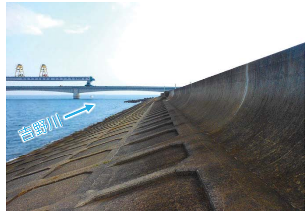
写真4. 吉野川河口の高潮堤防
