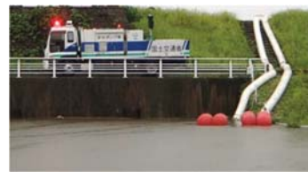
写真5.ポンプ車による排水状況
