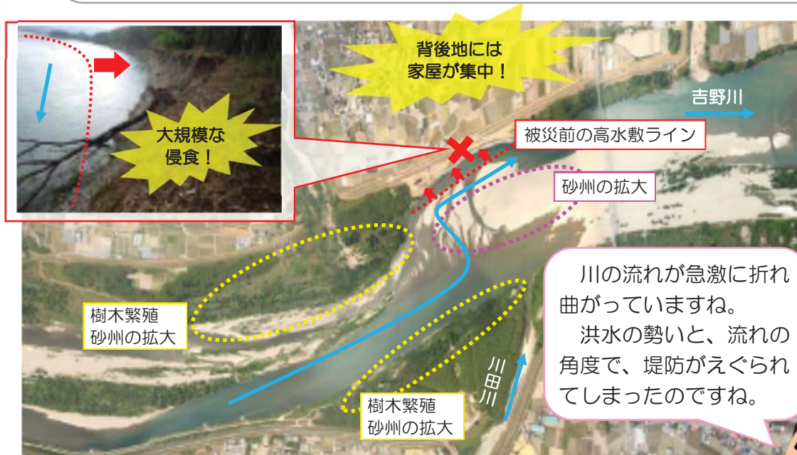
写真 3.西原箇所での侵食被害（平成 27 年 6 月撮影）
