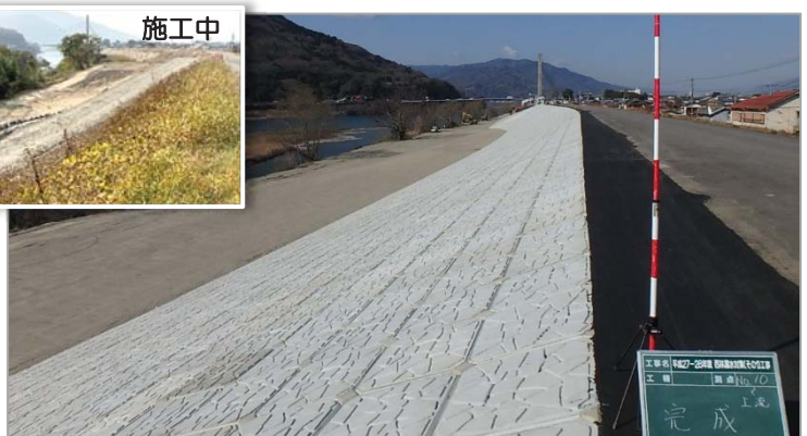
写真 2.漏水対策（西林箇所）完成イメージ（平成 27-28 年度工事箇所）
