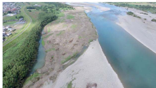
写真5. 着手後 令和2年10月撮影
