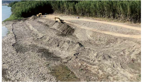
写真3. 着手後：令和2年9月撮影
