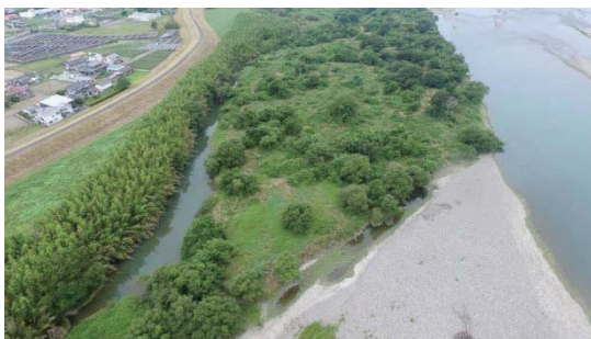
写真4. 着手前 令和2年6月撮影
