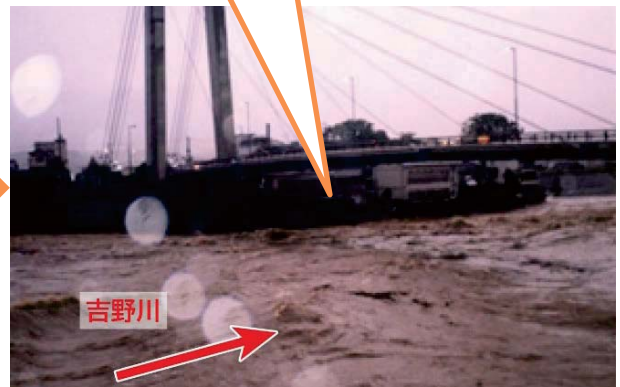
写真 5. 平成 16 年台風 23 号での岩津観測所の洪水状況
