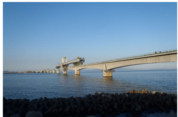
建設の進む高速道路橋
