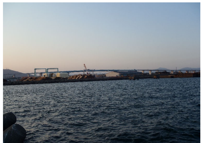
建設の進む高速道
