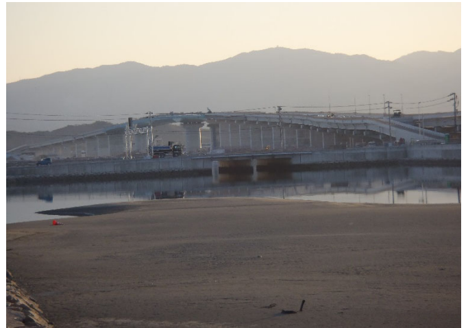
建設の進む高速道
