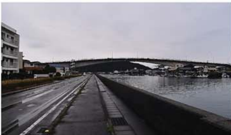
撫養川と撫養川大橋
