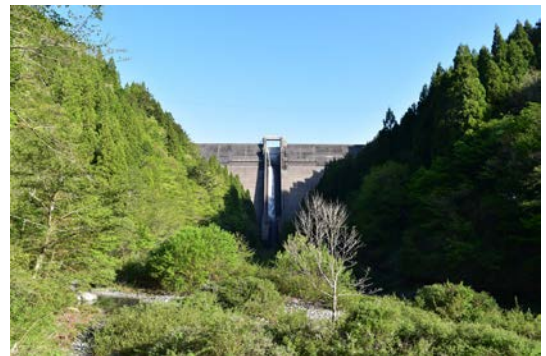
奥南川林道から見た大森川ダム
