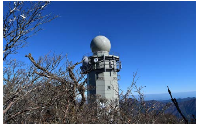
高城山にそびえ立つ高城山雨量レーダー
