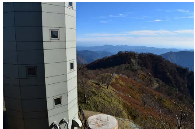
高城山雨量レーダーと南尾根
