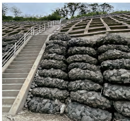
ダム湖法面と階段の様子
