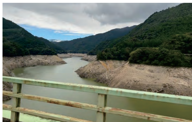
上流への道中に車内から撮影した水位低下の様子
