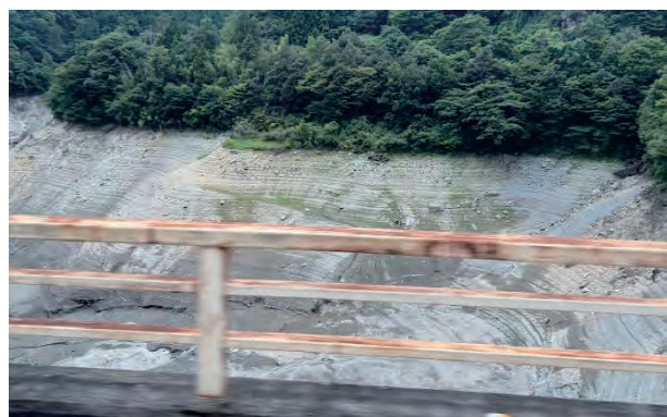
同じく車内から撮影、水がまったく流れていない
