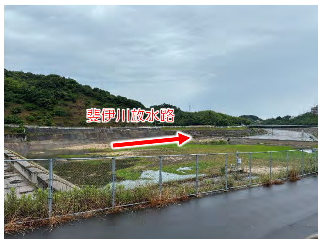
斐伊川放水路堰右岸から神戸川（斐伊川放水路）をのぞむ
