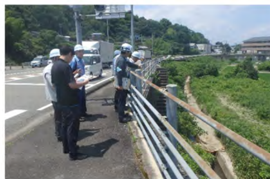
つるぎ町・東みよし町（青石橋付近）
