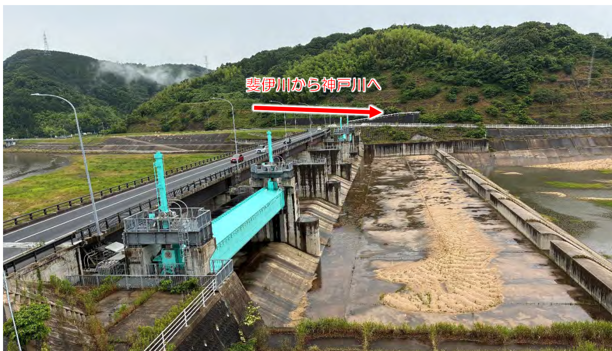
斐伊川放水路堰右岸から左岸をのぞむ
