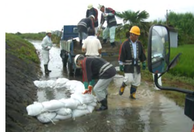
水防団による水防活動 (月輪工法)
