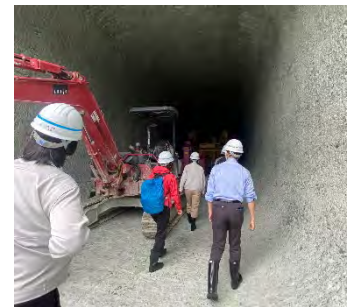
堤体に穴を開けている様子
