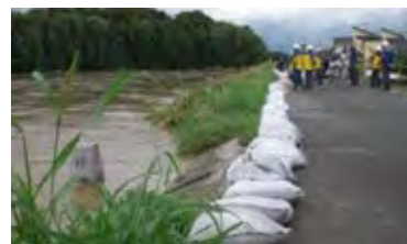
積み土のう工など 水防工法の実施
